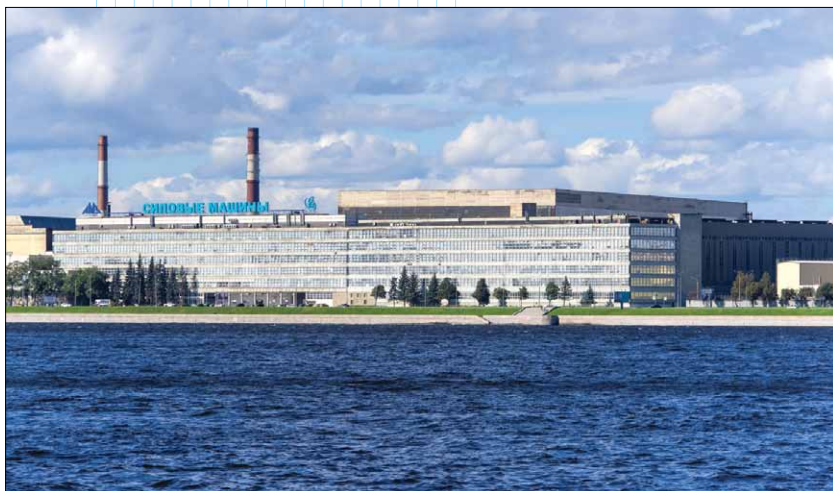
“Силовые машины”, Санкт-Петербург
