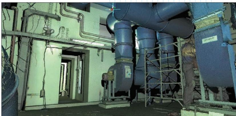
Рис. 7. Фрагмент облака точек, окрашенных в реальные цвета, полученный со встроенной фотокамеры
