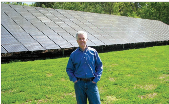
Гордость г-на Summers – фотогальваническая солнечная батарея во дворе офиса, обеспечивающая 25% потребления электричества и тепла
