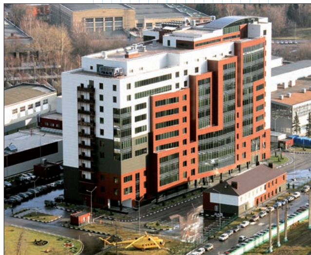
Новая площадка Национального центра вертолетостроения
